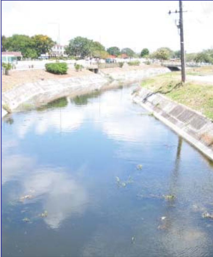
Fig. 4 y 5. Acciones de mejora a los tramos fluviales en la ciudad de Santa Clara.
